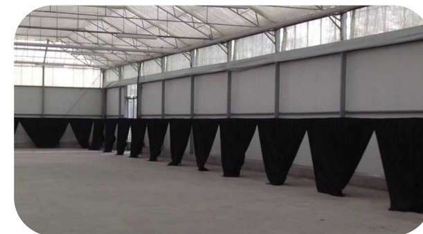
Habillage d'une salle
